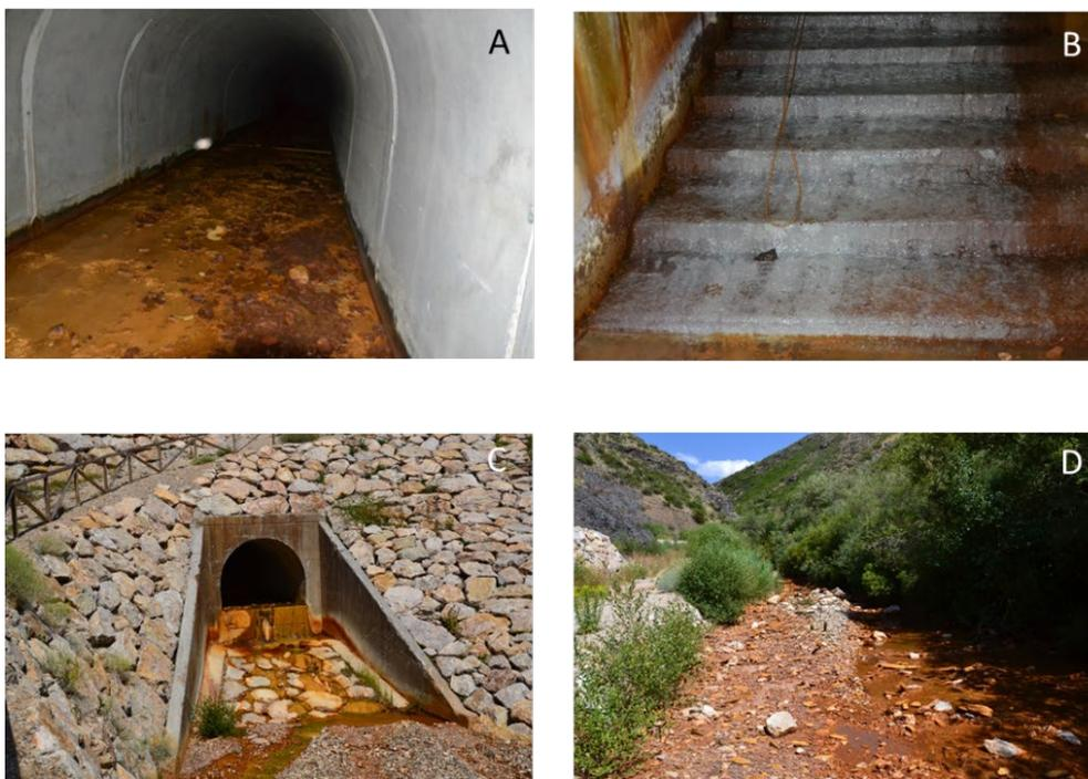
**Figura 5.** A) Precipitados de hierro en el interior del túnel (T-1), B) precipitados de aluminio y hierro en el interior del túnel, C) precipitados (LS-3) a la salida del túnel y D) en la estación LS-4, tras incorporarse el arroyo natural de La Retuerta.
