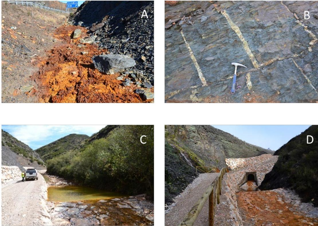
**Figura 1.** A) Precipitados de hierro en la cuneta de la autovía A6 en el PK 352, B) pizarras con filones de cuarzo y pirita, C) canal calizo con una balsa de decantación y D) túnel construido para conducir las aguas del arroyo La Silva, por su margen derecha se incorporan las aguas del arroyo de La Retuerta.
